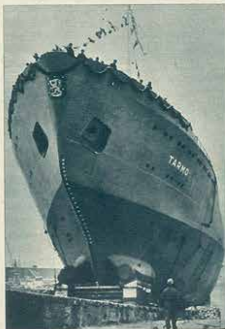
TARMO on vesillelasku. Kuvasta saa käsityksen jäänmurtajan rungon muodosta sekä keulapotkurien sijainnista. Varsinaiset potkurit asennetaan vasta telakoinnin yhteydessä.
